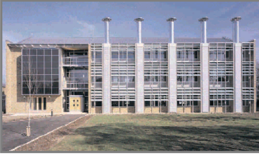
Şekil 1. Örnek binanın dıştan görünüşü.
