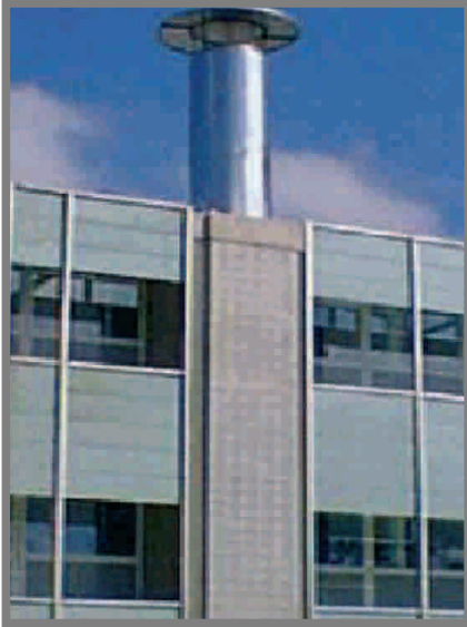
Şekil 7. Havalandırma bacası görünüşü.
